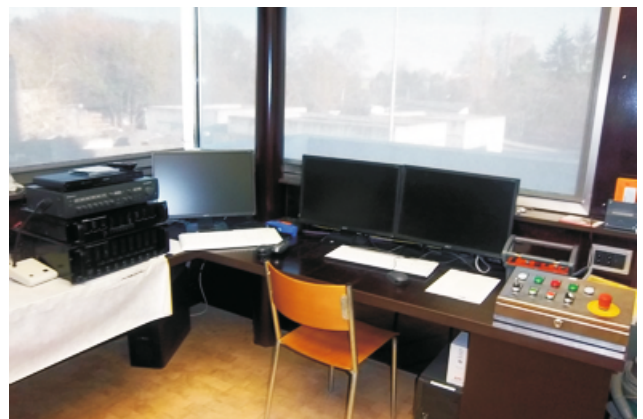
Salle de contrôle
